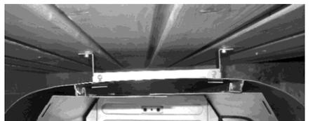
Figura 2 Montaggio del riscaldatore della sauna alla parete
