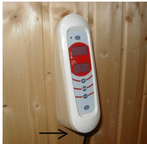
6. Il telaio si rimuove premendo con un'asta sottile o un piccolo cacciavite dalle scanalature (4) e ruotando con cautela verso l'esterno.
