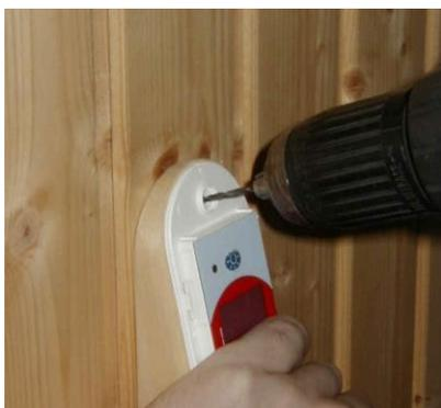
2. Posizionare il regolatore il più accuratamente possibile sulla base in legno e praticare un foro di 2-3 mm attraverso l'asse superiore fino alla base in legno. La profondità del foro non ha alcuna importanza, poiché il suo scopo è quello di facilitare la rotazione della vite nella base in legno.
