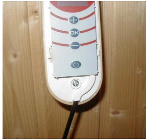
5. Posizionare il telaio del controller nella sua sede. Il telaio si posiziona nella sua sede premendo con le mani. Rimuovere, utilizzando ad esempio un coltello, la parte in plastica pre-lavorata riservata al cavo.
